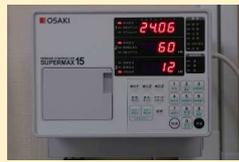
デマンド監視装置を設置しピーク電力を監視
