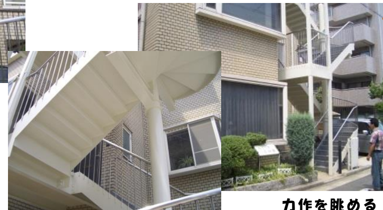
きれいになった階段の天井（上裏）
