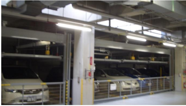
地下駐車場 の47本の蛍光灯がLEDに！
