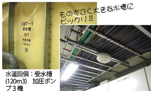
電気設備から延びる大量の配線
