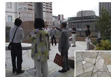
免震と非免震の境(クリアランス): ステンレス部分の下に隙間がある
