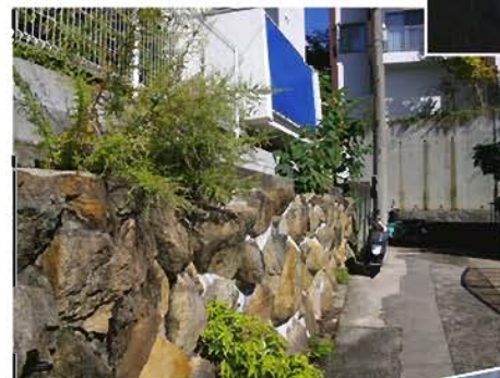
H21●ネットフェンスの更新と巨石積をモルタルで補修しました。
